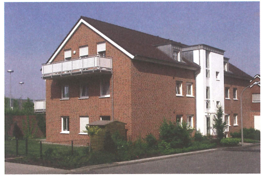
Fünffamilienhaus, Neubau Warendorf, Watertimpen.
