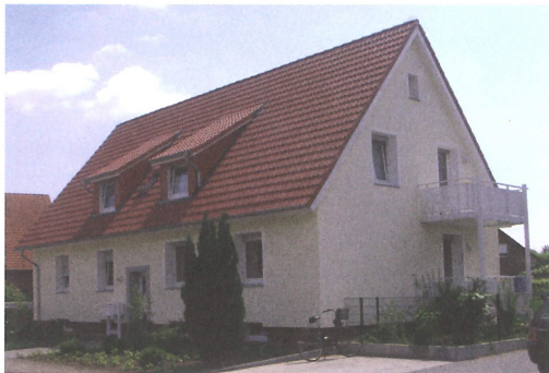
Vierfamilienhaus in Sassenberg, Breslauer Straße, erbaut im Jahre 1952, seit 2006 mit Vollwärmeschutz, neuem Dach und Balkonanlagen.
