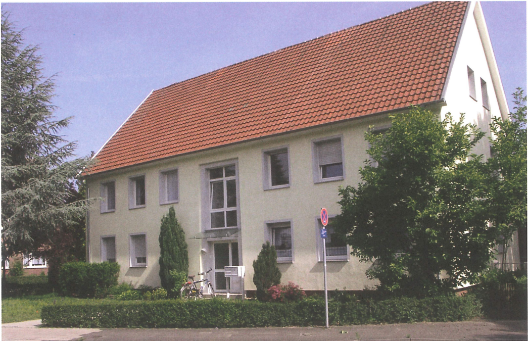
Im Jubiläumsjahr erhielt dieses Gebäude in Warendorf an der Reichenbacher Straße mit dem Vollwärmmedämmenschutz ein moderneres Erscheinungsbild. Das Haus stammt aus dem Jahre 1955.
