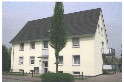
Vierfamilienhaus in Freckenhorst, Everswinkeler Straße. Wie viele andere wurde auch dieses Gebäude mit einem Vollwärmeschutz und Balkonen modernisiert.
