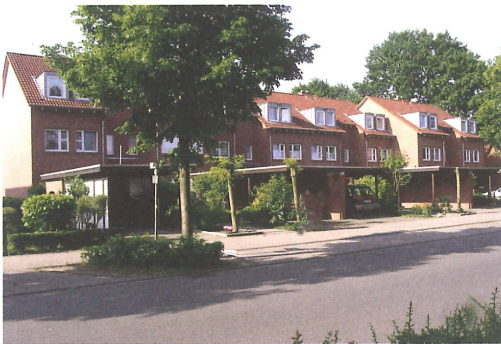
Acht Mieteinfamilienhäuser in Warendorf, am Südring.
